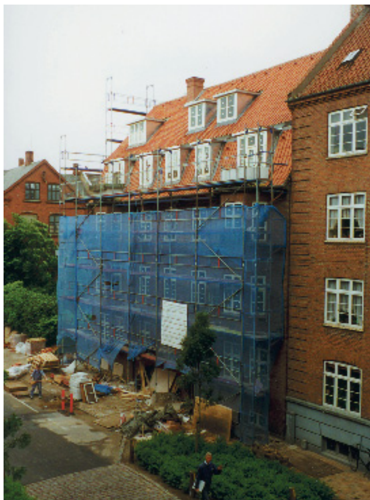
Figur 8. Gedefacade af Godthåbsgade 61A, Odense under renovering.
