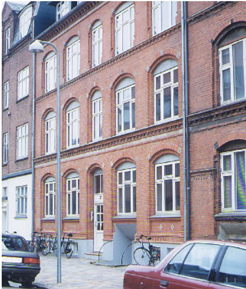
Figur 9. Gadefacade af Jagtvej 30, Odense efter renovering.
